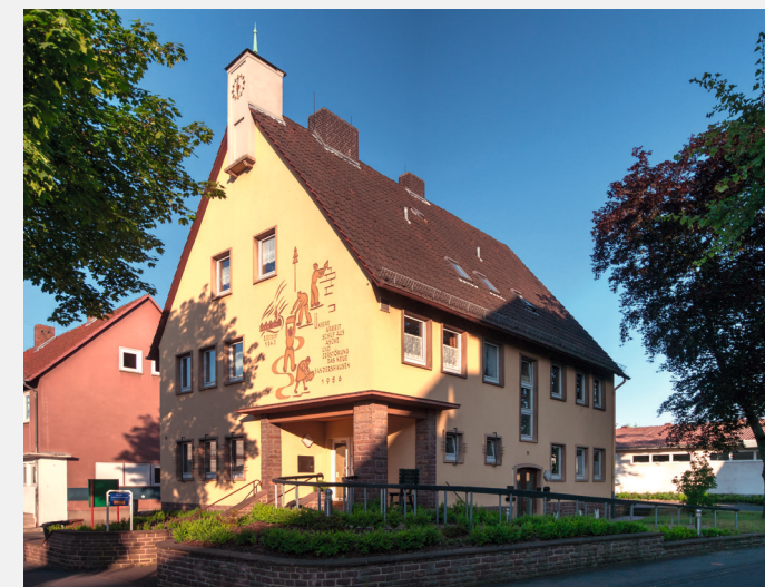
Ehemaliges Bürgermeisteramt Hannoversche Str. 79
